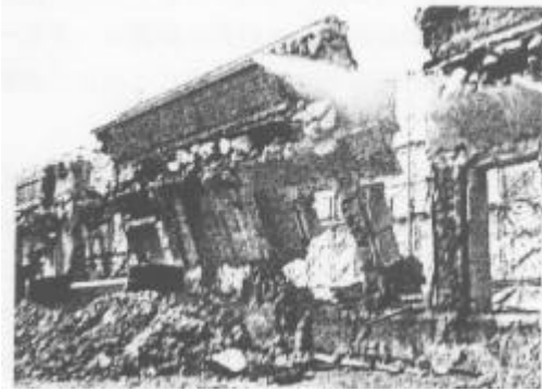
写真 2.9.1 転倒工法(昭和 38 年頃)
