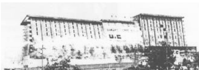
写真 2.9.7 爆破解体工法(平成 4 年)
