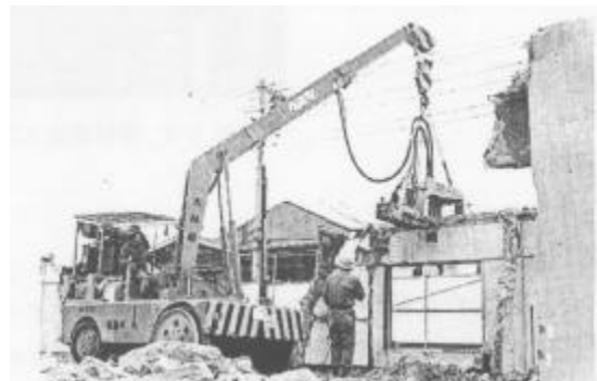
写真 2.9.6 初期の圧砕工法(昭和 53 年頃)
