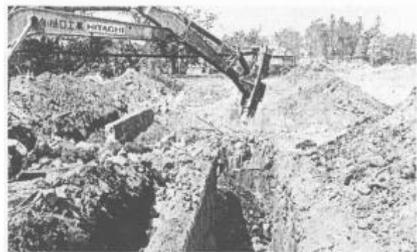
写真 2.9.4 大型ブレーカ工法
