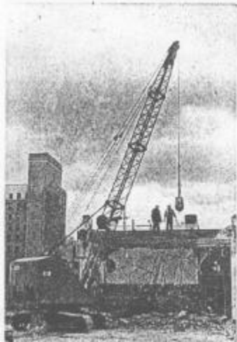
写真 2.9.3 スチールボール工法
