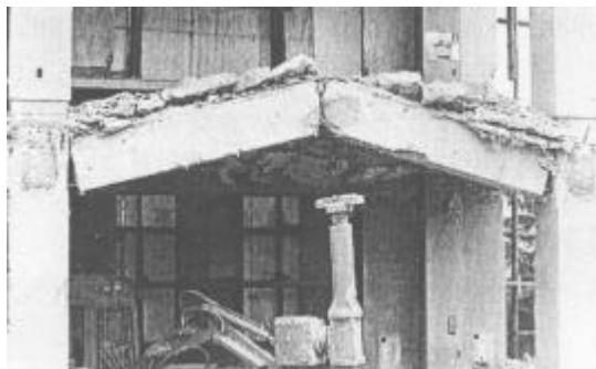
写真 2.9.5 ジャッキ工法
