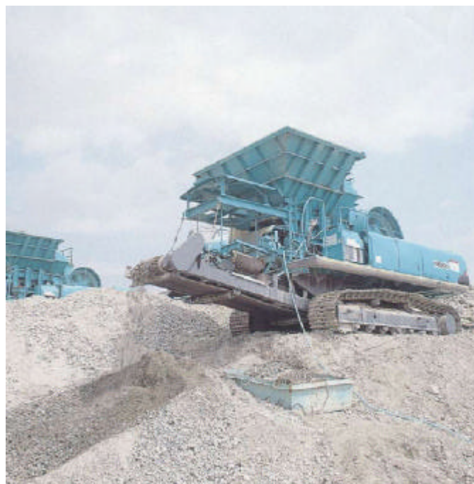
写真 2.9.11 解体コンクリート塊の現場内処理状況
