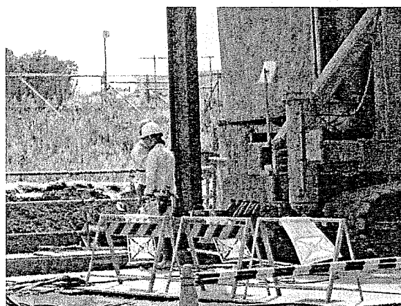
写真一五 芯材投入状況（後日撮影）
