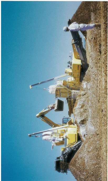
リトラBZ200を2台1台ずつ投入、土質改良の作業は急ピッチで進んだ
