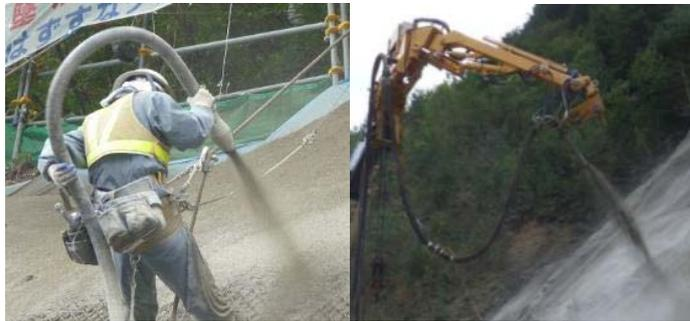
写真-1 ノズルマンとロボットアームの違い
