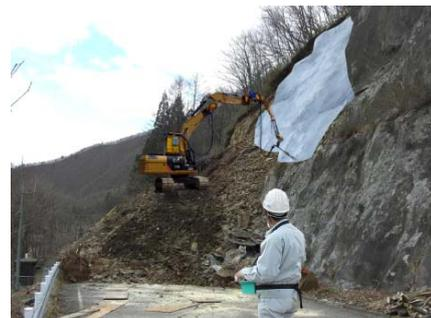
図-2 遠隔操作施工イメージ
