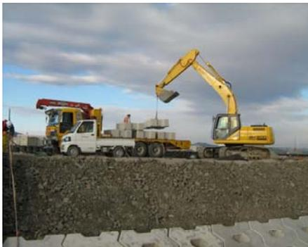
斜吊りによる玉掛け(据付け作業)
