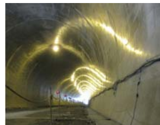
覆工コンクリート仕上がり状況
