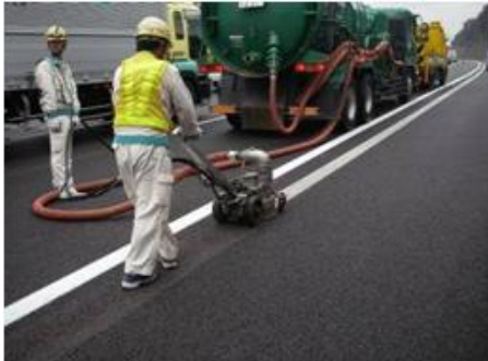
区画線消去作業状況
