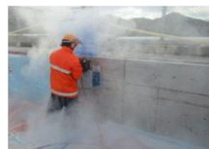
塗装剥離工事
