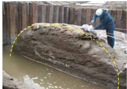
写真-1 浸透注入により改良された地盤
