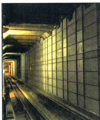
写真-1 「ブロック分割除去工法」 囲い込みパネル取り付け全景
