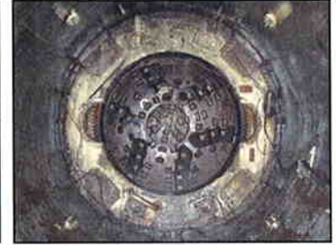
写真-3 止水完了状況
