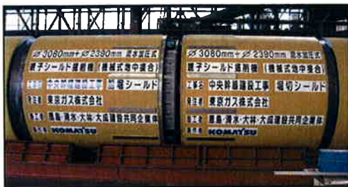
写真-1 接合(貫入)状況
