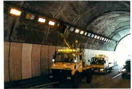
図-1 トンネル照明器具の清掃状況
