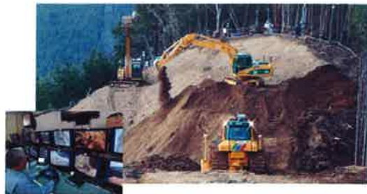
写真-1 北股地区無人化施工状況
