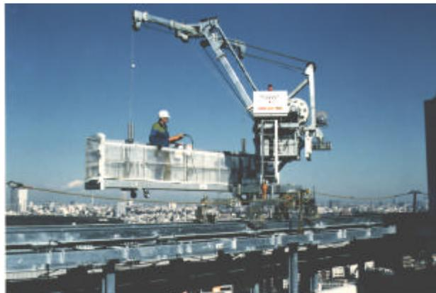
写 2.7.12 アーム俯仰型ゴンドラ (軌道式・ゲージ式・元旋回・先端旋回)
