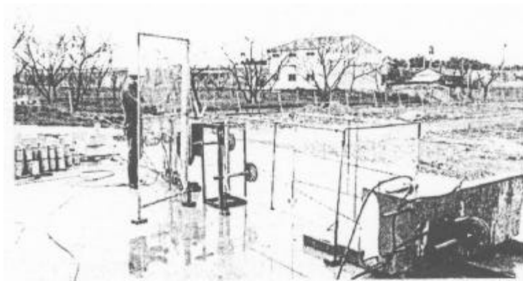
写真 2.9.10 ワイヤソーによる鉄筋コンクリートの切断状況
