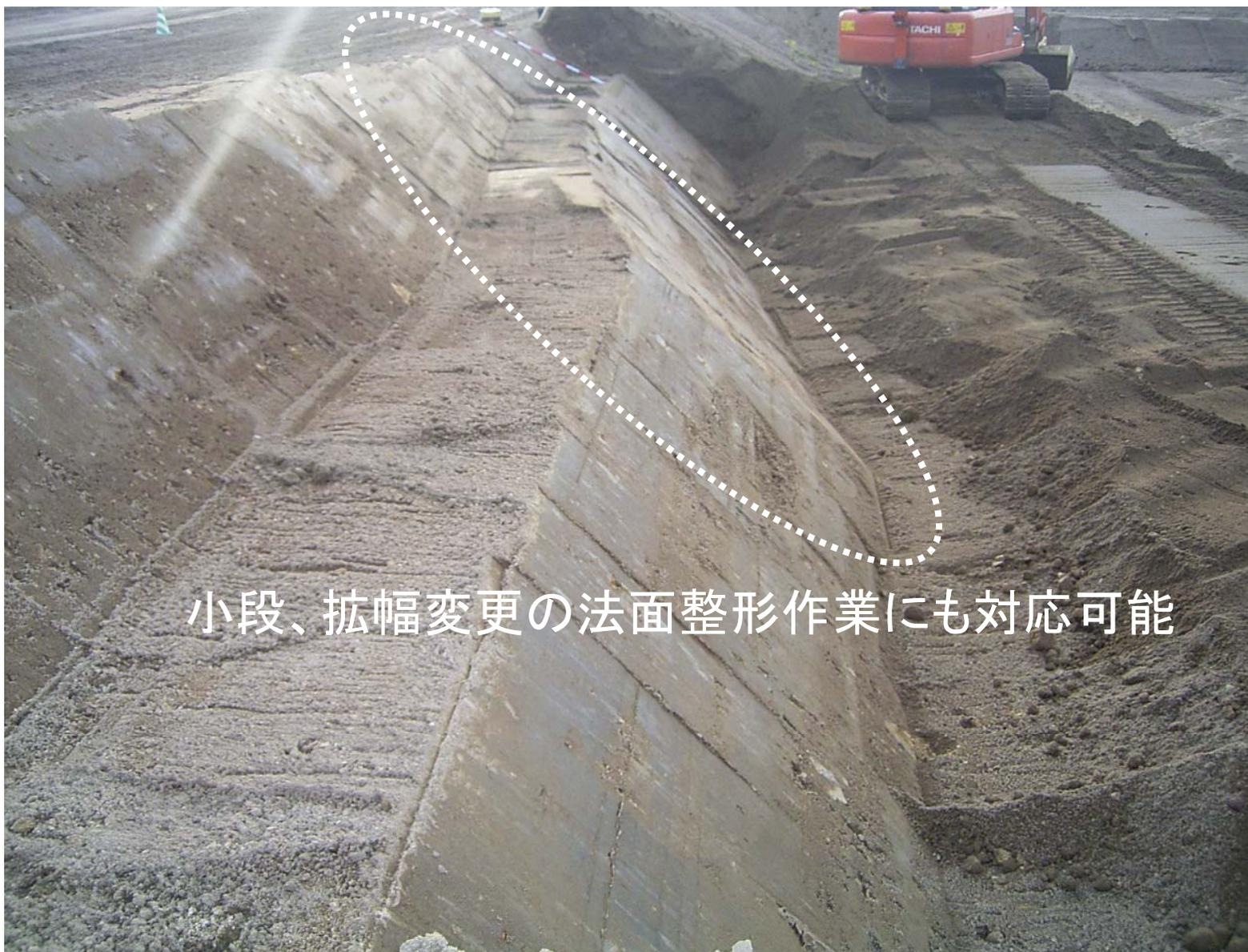
小段、拡幅変更の法面整形作業にも対応可能
