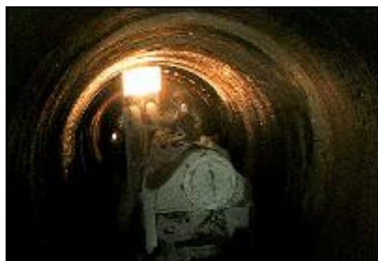
吹き付け状況
