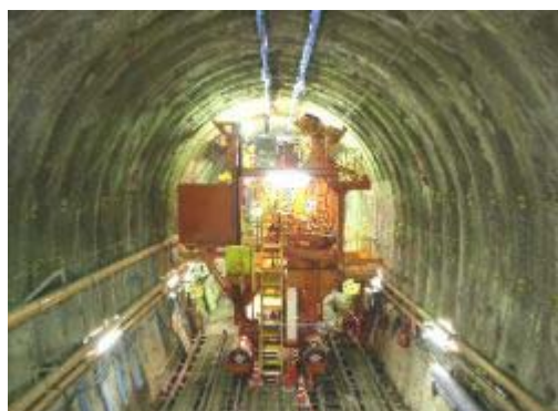
PSS施工状況（全景）
