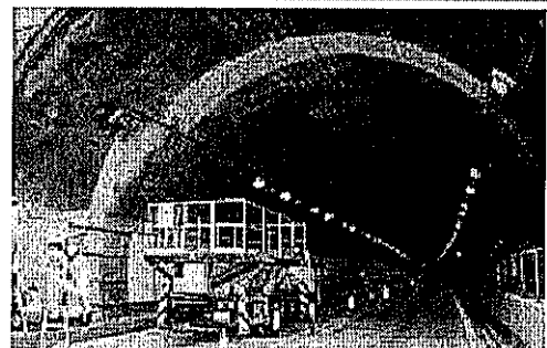
■繁藤トンネル補修工事状況
