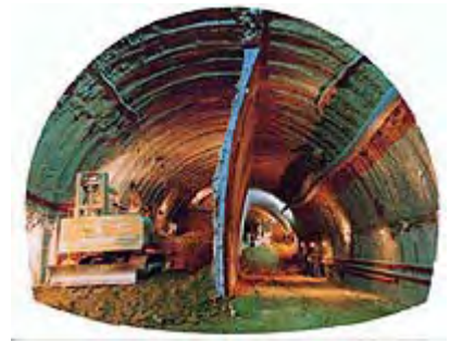
札幌市交通局 月寒トンネル
