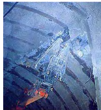
中壁撤去作業
