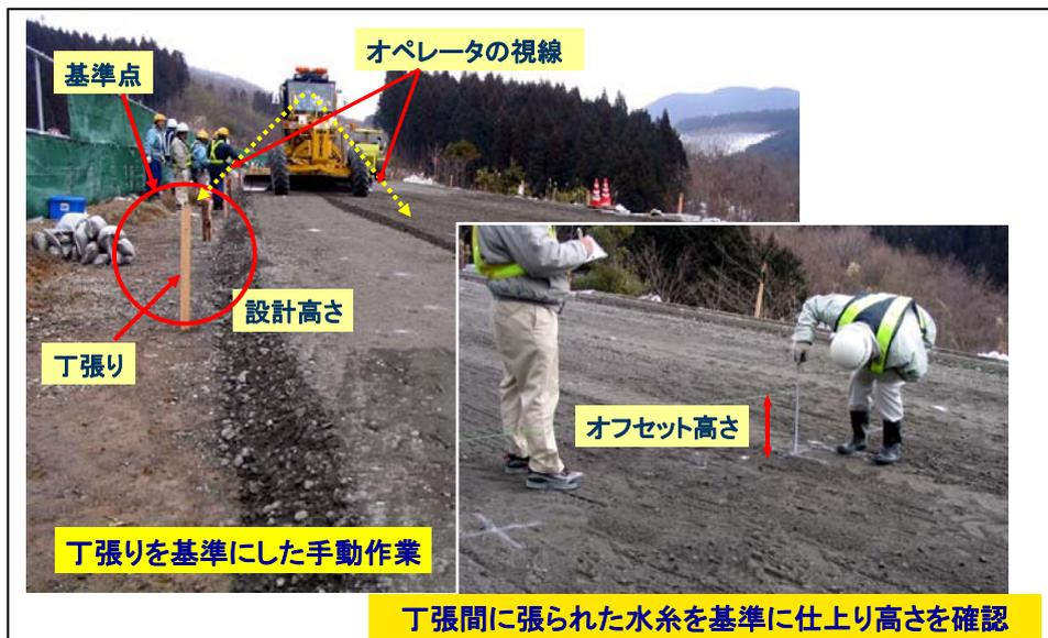
舗装工事、構造物打設工事などで、予め測量作業によって設置された操作基準線
