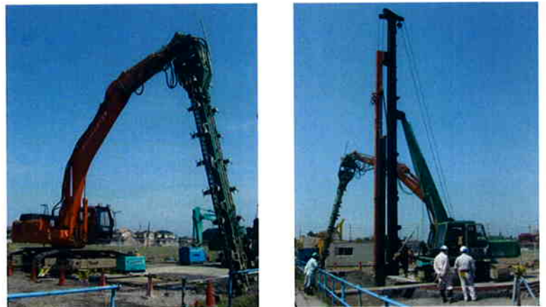
図-2 トレンチャー式地盤改良機（左）とシート展開装置（右）
