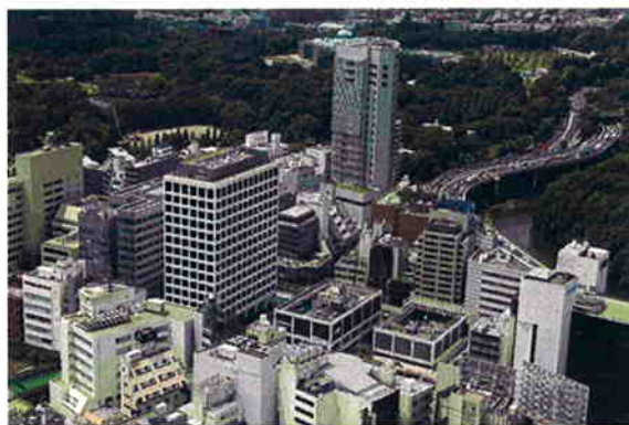
図1 解体前及びジャッキダウンの完了
