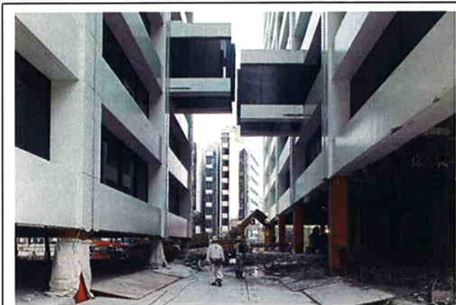
図2 ジャッキダウン中の渡り廊下
