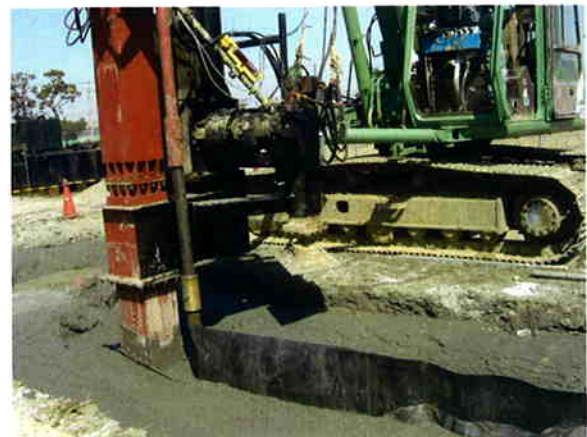
図-3 シート横引き展開状況
