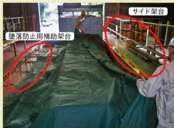
シート掛け作業風景
