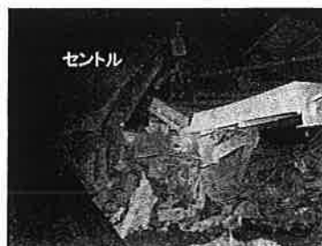
坑口から約550m地点(総務省消防庁提供)
