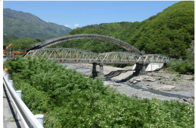
現早川橋(手前)と架設中の新早川橋
