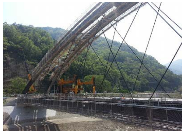
床版架設状況
