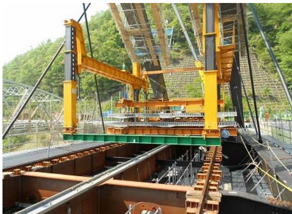
PC床版架設機
