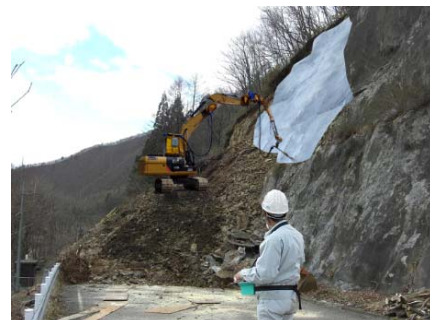
図-2 遠隔操作施工イメージ
