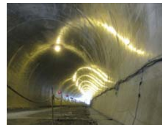
覆工コンクリート仕上がり状況
