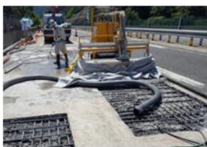
橋梁床版補修工事
