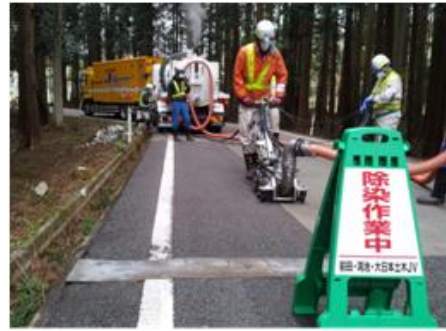
除染作業状況
