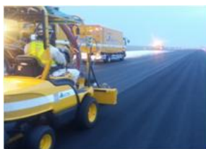
滑走路ゴム除去工事
