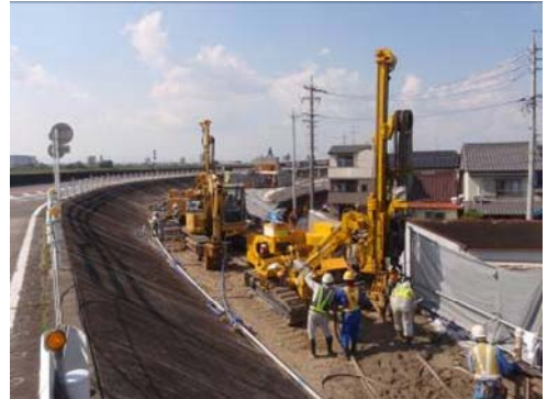
既設河川堤防上における施工状況
